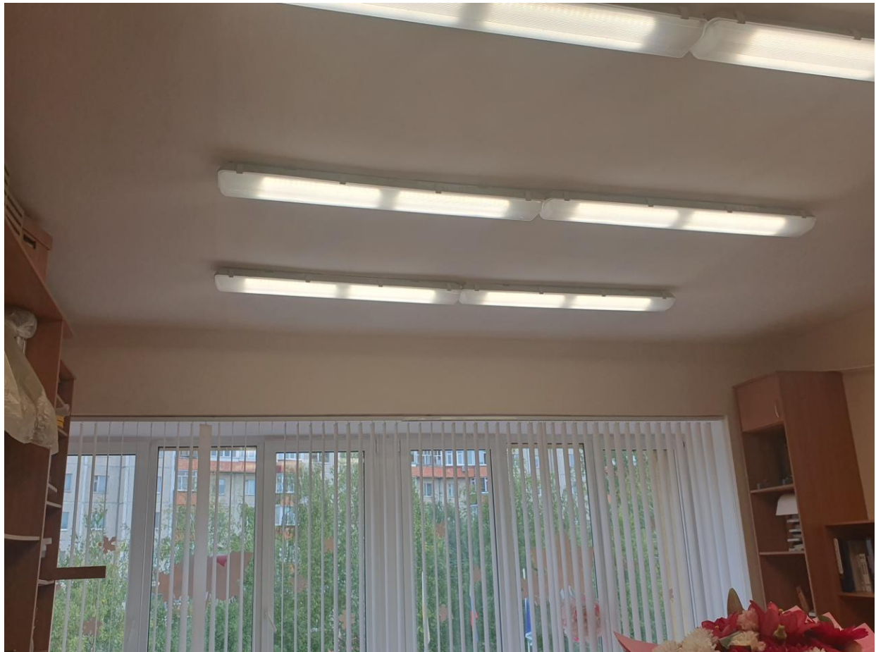
Фото№3 Кабинет 308 (произведен полный косметический ремонт помещения)
