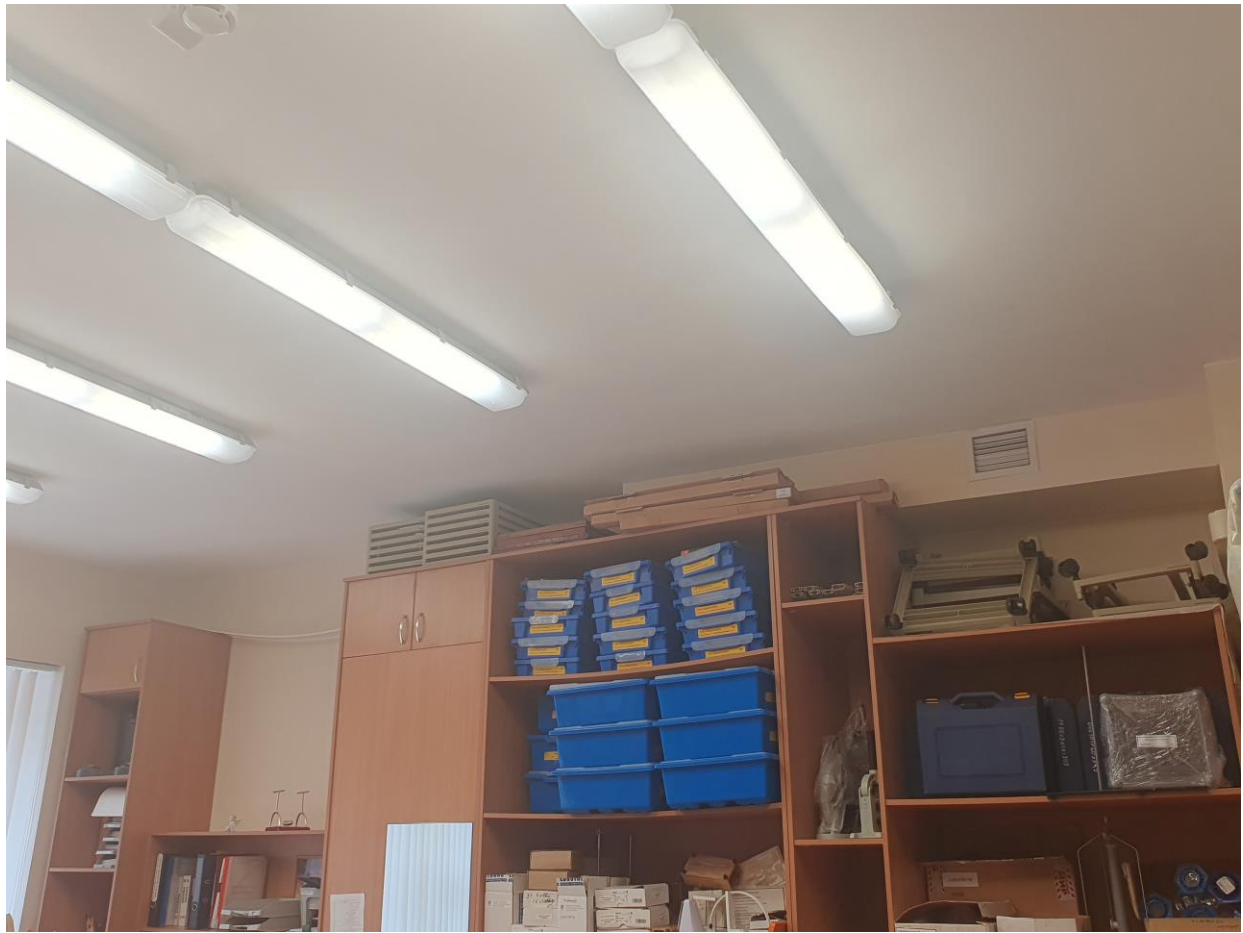
Фото№2 Кабинет 308 (произведен полный косметический ремонт помещения)
